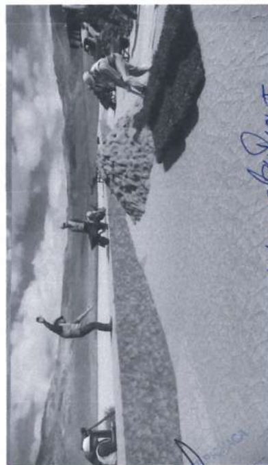
CONFORMACIÓN DE ESPALDÓN CON CHAMPA, MANUAL.
