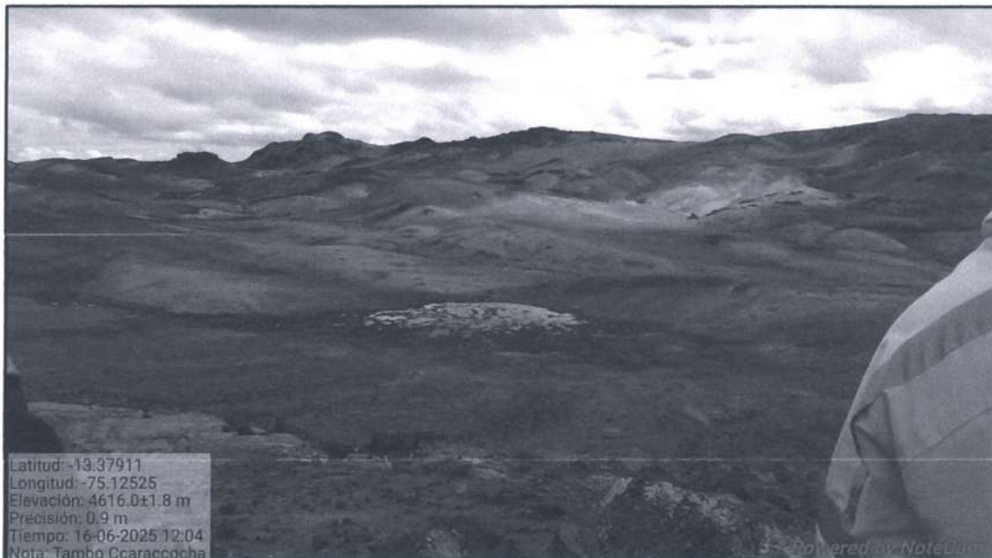
Imagen: Dique 1 Volumen Actual 248 M3, luego de la construcción del Dique Tendrá Capacidad Máxima de 1,595.37 M3.
