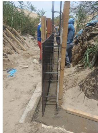
Ampliación del canal de ingreso de agua a Gola Meir.
