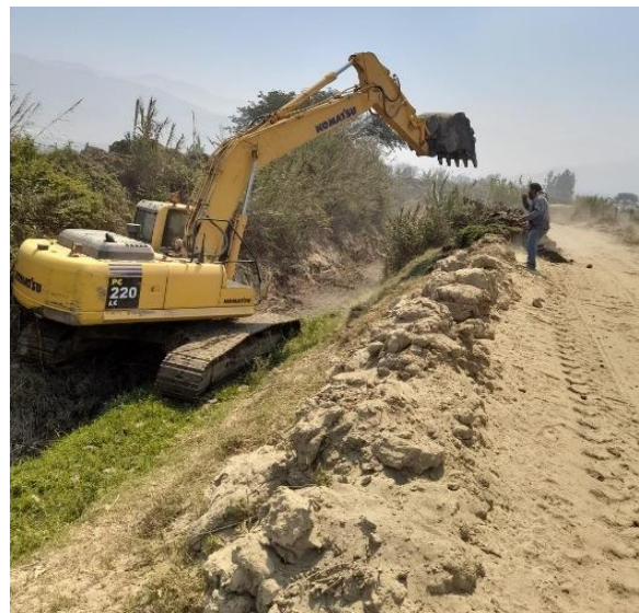
Acondicionamiento del Canal Macacona y La Mauricia.
