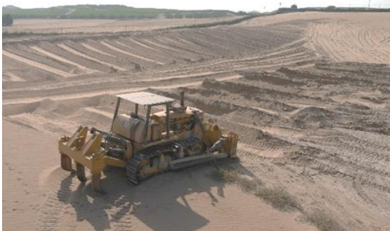
Construyendo uno de los dos (2) diques.
